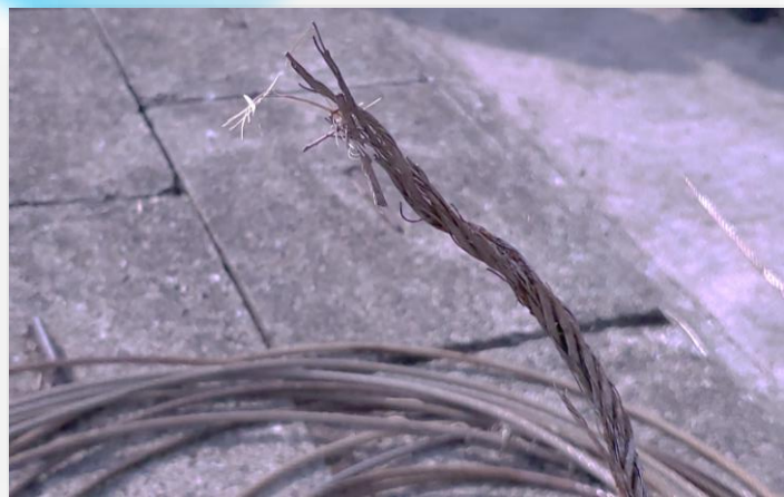
破断した従来型掻寄機のワイヤーロープ
