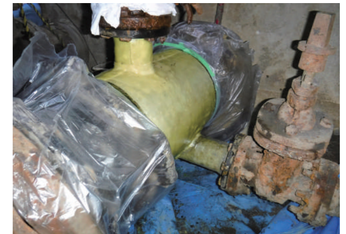
【管路の非溶接補修】 FRPを用いて老朽配管や分岐配管等の難施工箇所を補修
