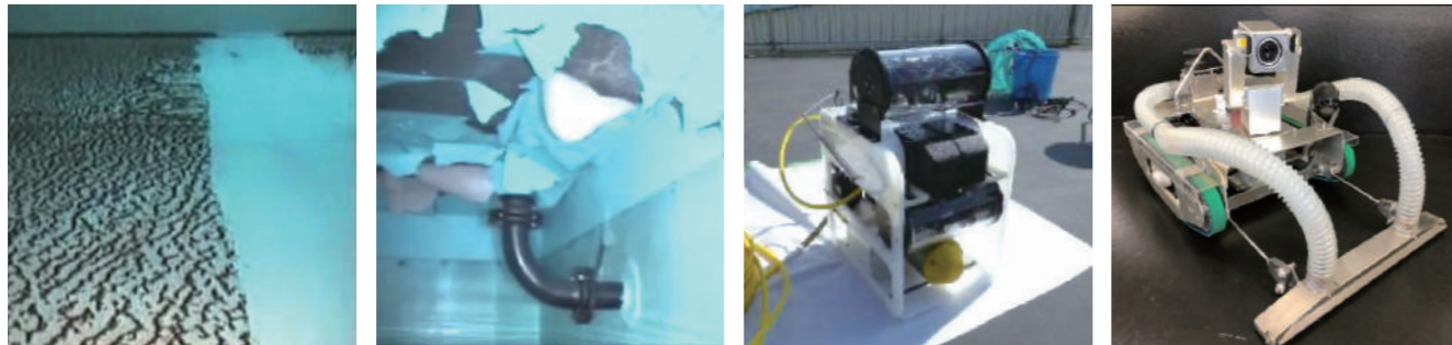
底版・清掃前後 頂版・塗装はがれ 点検ロボット 清掃・点検ロボット
