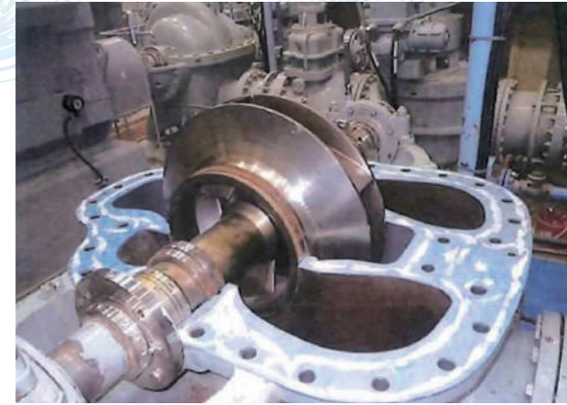
【各種設備の分解整備】 浄水場内外の各種設備の分解整備や部品交換を実施
